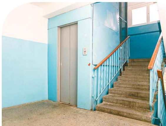
Подъезд дома № 1 на улице Менделеева
